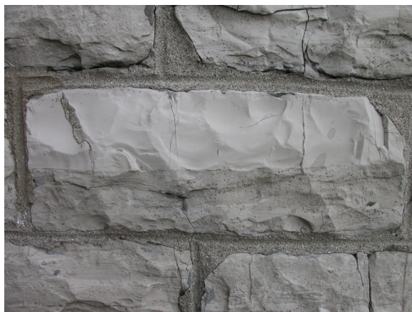
Calcaire de Château-Richer: maçonnerie de parement et photomicrographie (50x).
