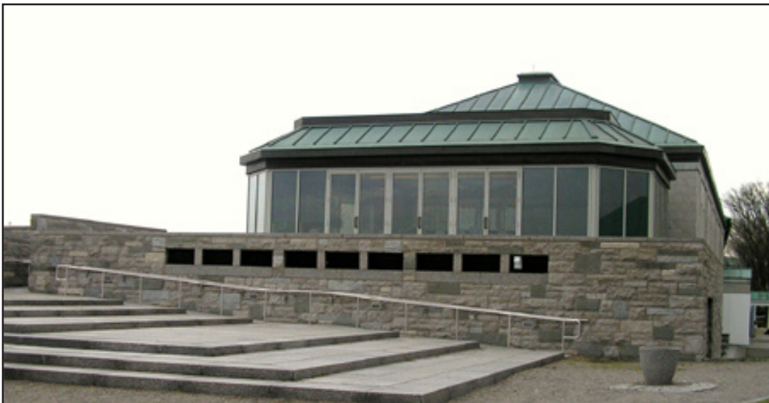
Partie moderne de la Résidence inaugurée en 1984. Le mur de soutènement est formé d'un mélange incluant : calcaire de Saint-Marc-des-Carières, grès de Saint-Pie-de-Guire, calcaire d'Indiana, granite de Stanstead. Le pavé est en granit Calédonia de Rivière-à-Pierre.
