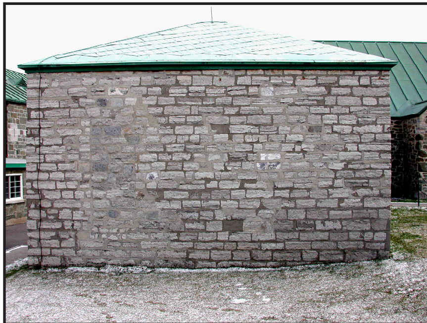
Mur arrière de l'Ancienne Tonnellerie montrant les travaux de restaurations des années 1930 et 1949.
