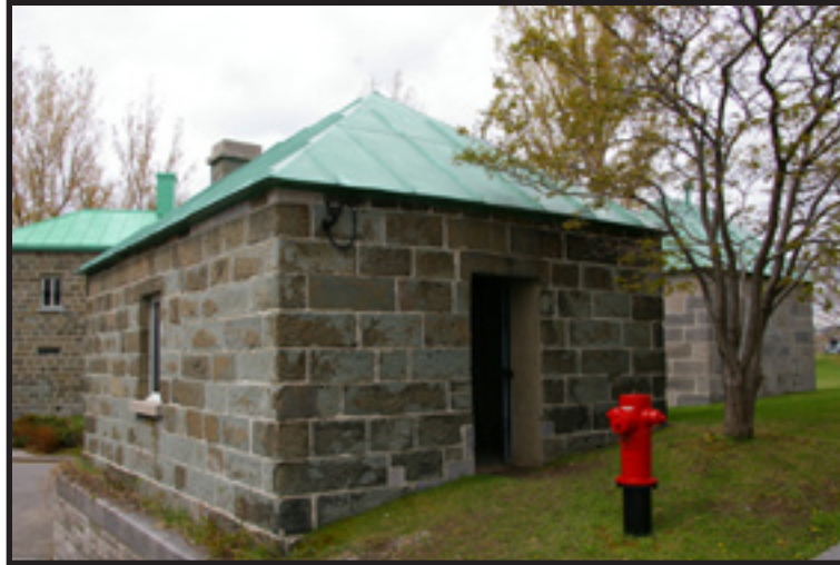
Ancienne Maison des pompes en grès de Sillery.
