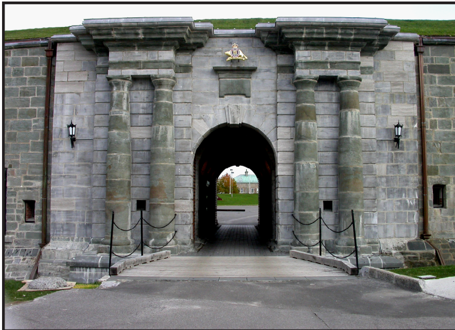
Porte Dalhousie construite en 1827, colonnes toscanes et corniches en grès de Sillery, mur en calcaire de Pointe-aux-Trembles.
