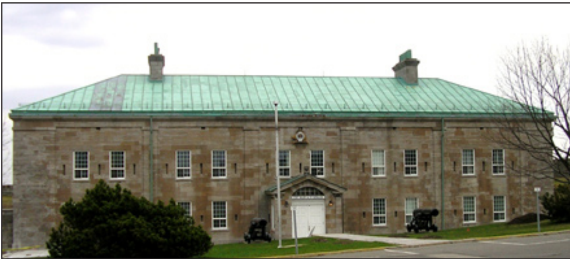
Ancien Hôpital avec façade et murs latéraux en calcaire de Pointe-aux-Trembles altéré brun.
