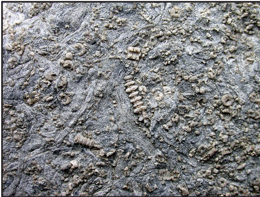
Surface chagrinée d'un bloc de calcaire de Pointe-aux-Trembles de la façade du bâtiment montrant de nombreux fossiles de Bryozoaires et de Crinoïdes.
