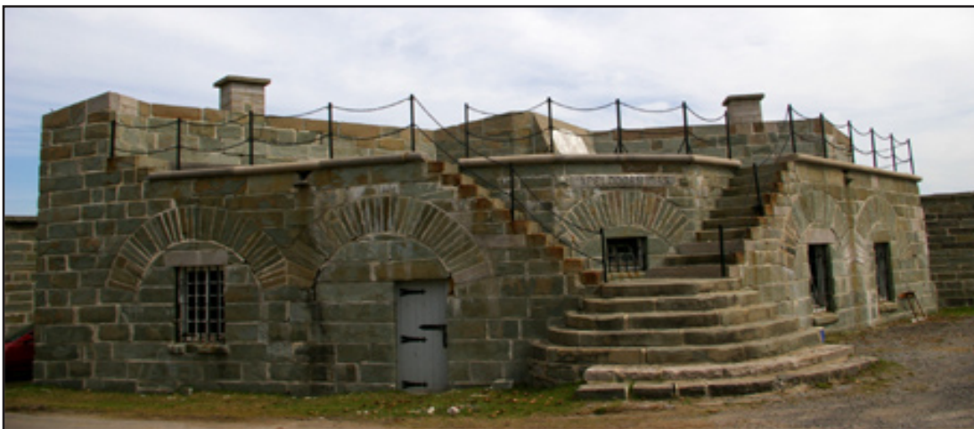
Réduit de Jebb en grès de Sillery.
