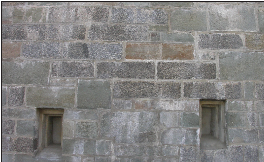
Fig. 16-Blocs de granit de Rivière-à-Pierre gris foncé remplaçant le grès de Sillery verdâtre ou brun.
