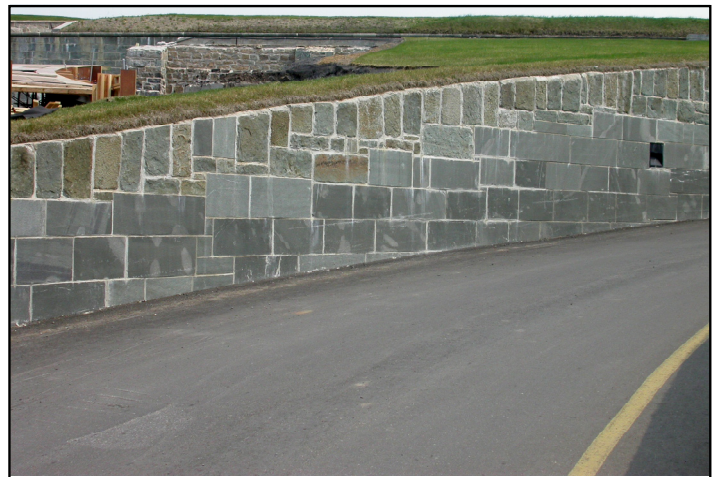
Section du mur de l'entrée de la Porte Durnford montrant le remplacement de blocs de grès de Sillery par du grès de Tourelle.
