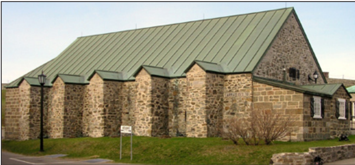
Ancienne Poudrière construite en 1750 sous le Régime français en pierres de champs posées à tout-venant. L'annexe à droite construite sous le Régime britannique est en blocs équarris de grès de Sillery.
