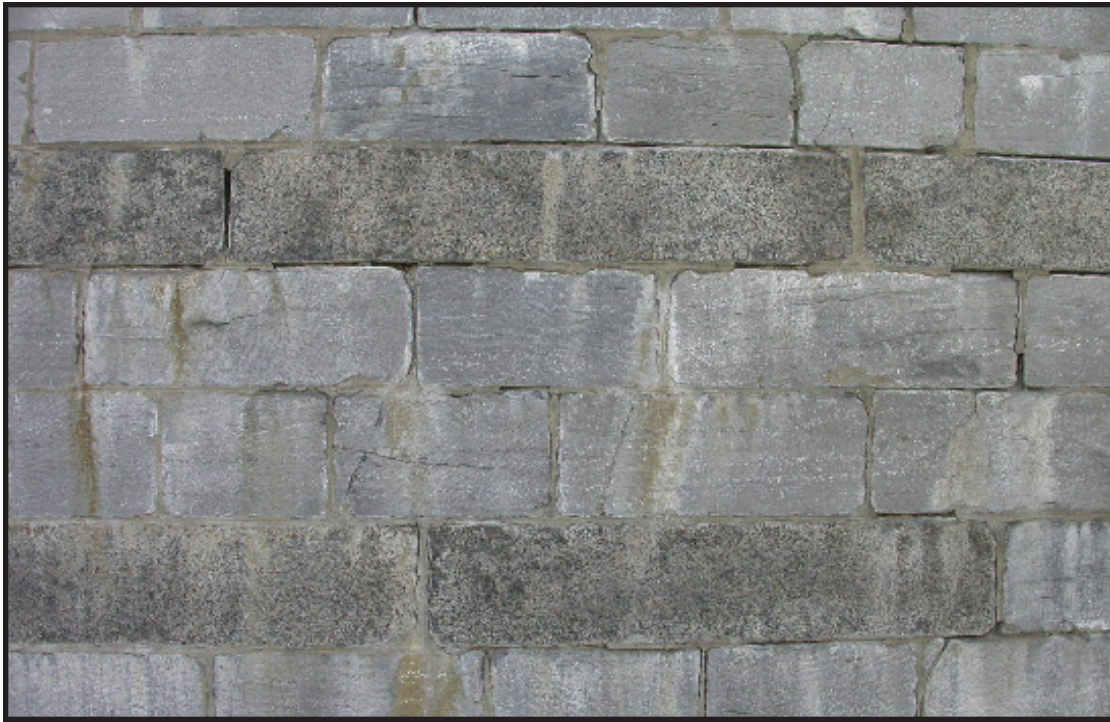
Blocs de granit de Rivière-à-Pierre remplaçant deux assises de calcaire de Pointe-aux-Trembles.
