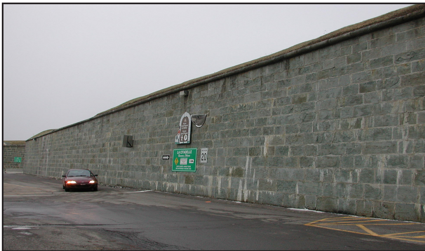
Mur d'escarpe en grès de Sillery construit entre 1820 et 1829 à la sortie de la Porte Durnford.
