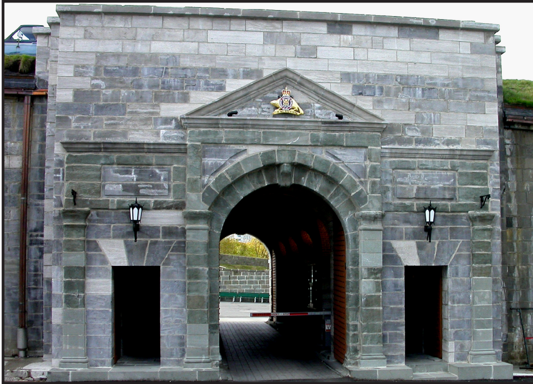
Porte Dalhousie intérieure avec pilastres et ornements en grès de Sillery, attique en calcaire de Pointe-aux-Trembles restauré avec du calcaire de Saint-Marc-des-Carières.
