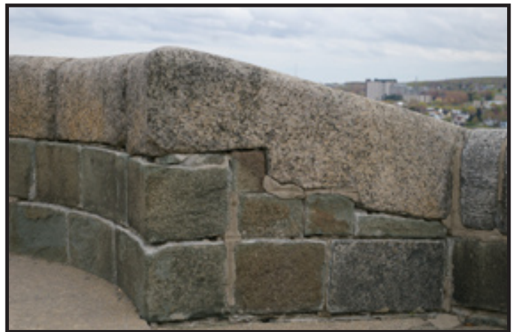
Muret en grès de Sillery et chaperon en gros blocs de granit de Rivière-à-Pierre.
