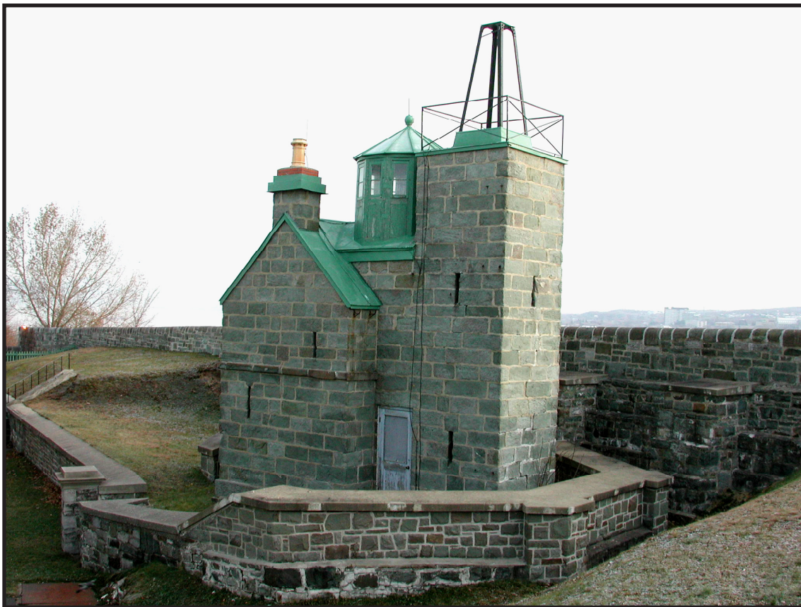
Les murs de l'Ancien Observatoire sont en pierres dressées de grès de Sillery.
