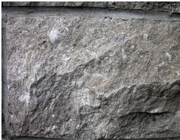
Calcaire de Saint-Marc: maçonnerie de parement et photomicrographie (13x).
