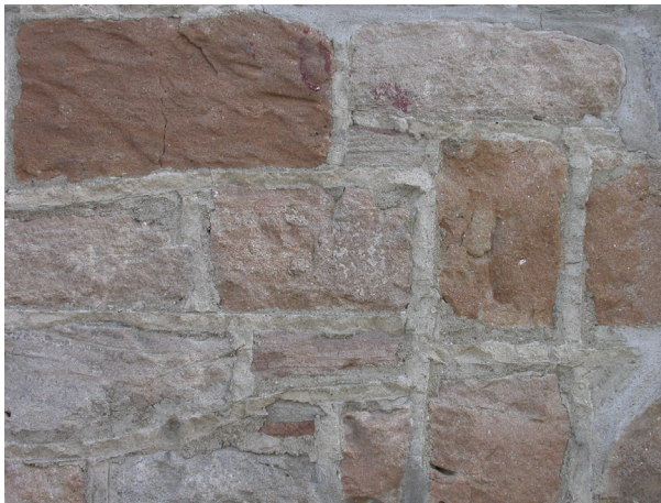
Grès de l'Ange-Gardien: maçonnerie de parement et photomicrographie (13x).
