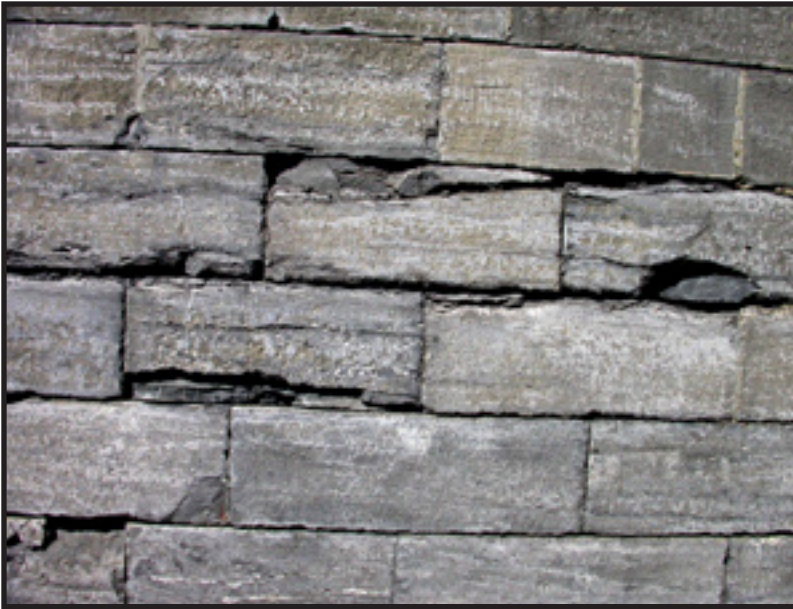
Mur du Ravelin Sud en Calcaire de Montréal.
