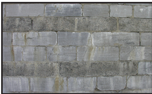
Deux assises de granit de Rivière-à-Pierre remplaçant le calcaire de Montréal
