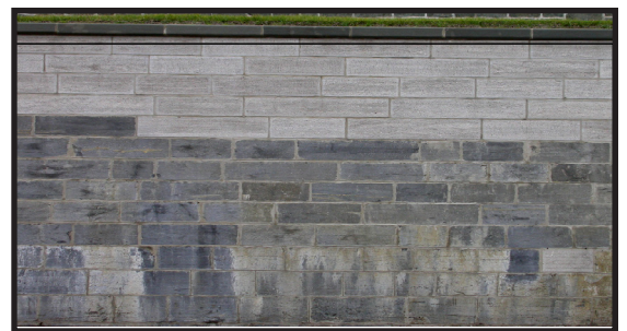
Calcaire de Saint-Marc-des-Carières (haut) remplaçant le calcaire de Montréal (bas)
