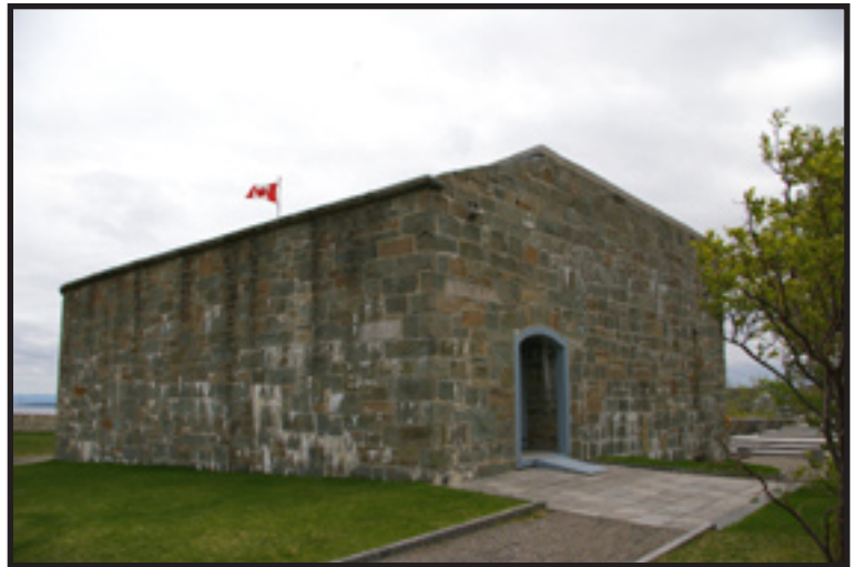
Redoute du Cap-aux-Diamants en grès de Sillery.
