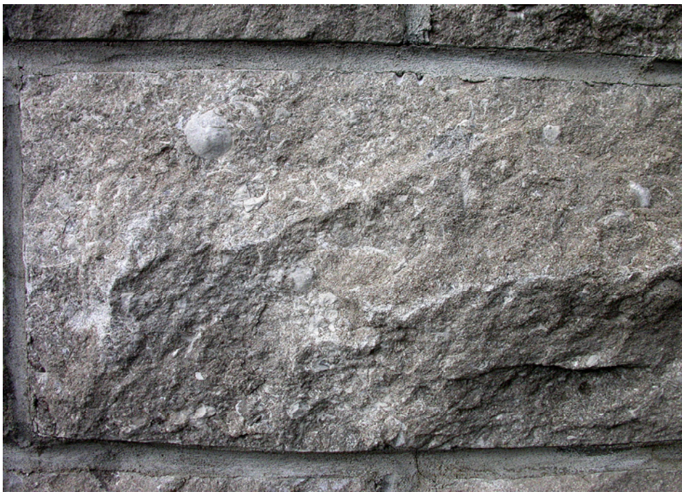
Bloc du parement en calcaire de Saint-Marc-des-Carières à bossage rustiqué riche en Bryozoaires Prasopora .
