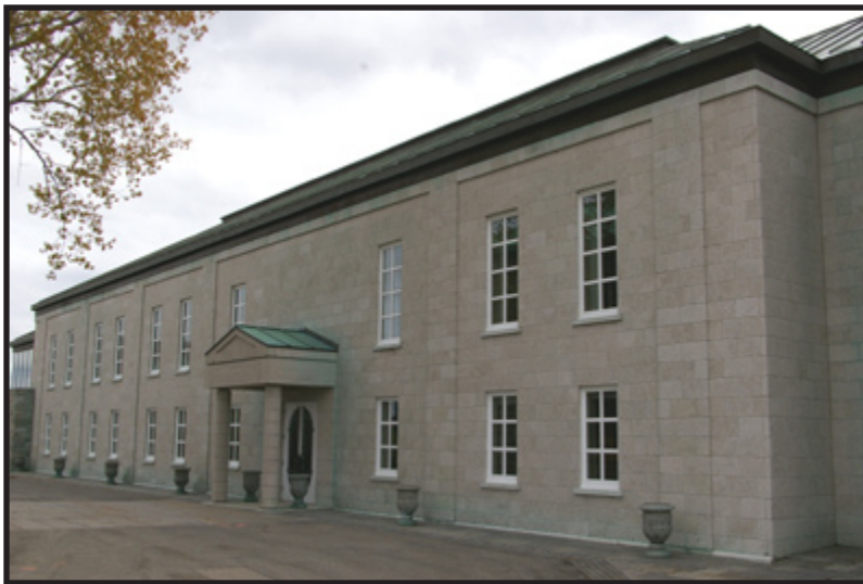
Résidence du Gouverneur général du Canada reconstruite après l'incendie de 1976 avec parement en calcaire de Saint-Marc-des-Carières.
