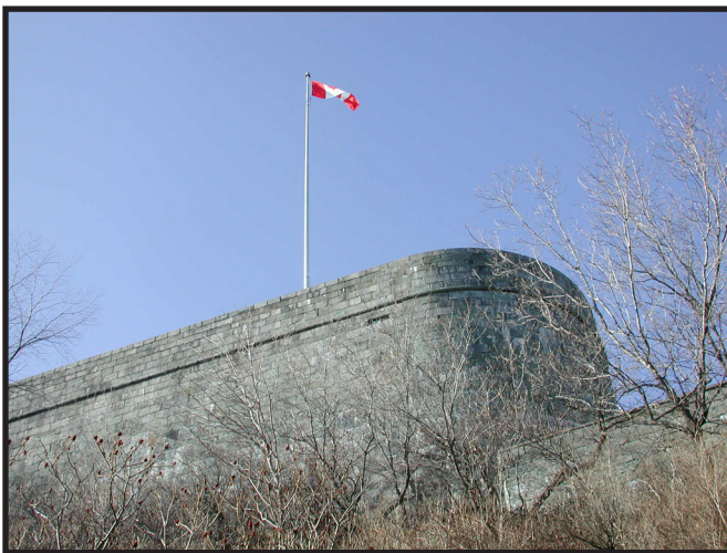
Bastion du Roi en grès de Sillery vu de la terrasse Dufferin.
