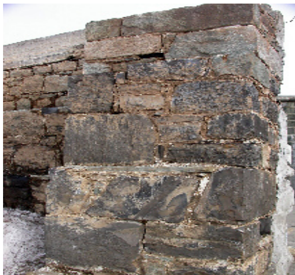
Pierre noire du Cap: maçonnerie brute d'un mur et photomicrographie (50x).
